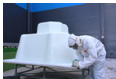
Ugradnja i obrada kompozitnog korita
